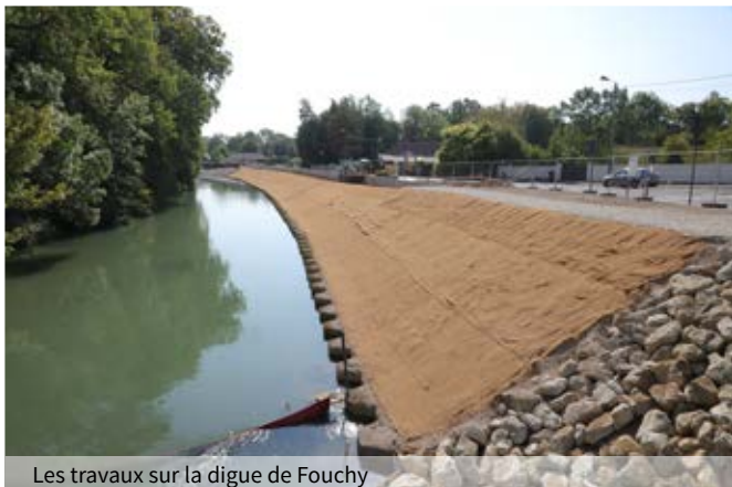
Les travaux sur la digue de Fouchy
