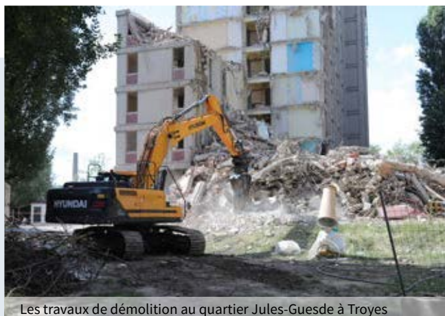
Les travaux de démolition au quartier Jules-Guesde à Troyes
