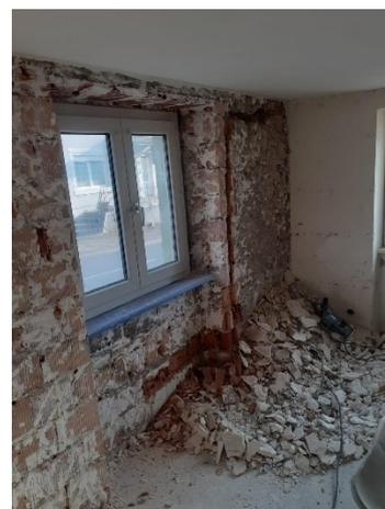
Les deux agents techniques municipaux, Fabrice HUMMEL et Matthieu WURTZ, qui disposent des compétences et qualifications nécessaires, se sont rapidement mis à pied d'œuvre et ont d'ores et déjà entrepris l'ensemble des travaux suivants : remise à neuf du réseau électrique ainsi que de la distribution sanitaire, remplacement du système de chauffage, reprise des plafonds et des sols, doublage de l'isolation intérieure ainsi que mise en peinture.
