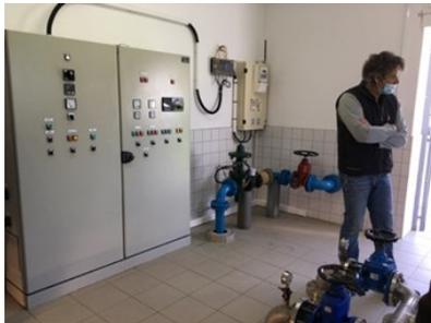
*au fond, la vanne de connexion avec le réseau du syndicat de Schlierbach*
