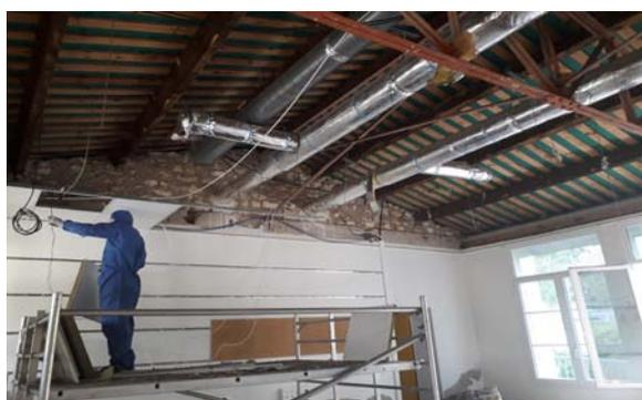
Dépose et repose des faux plafonds et installation de l'éclairage LED et des dalles de chauffage
