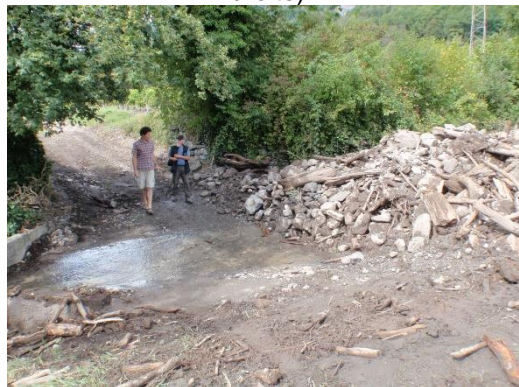
Figure 74 : Dépôt de matériaux lors de la crue de septembre 2016 sur le radier communal
