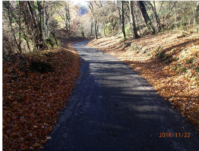
Figure 58: Route de Montplan canalisant les écoulements
