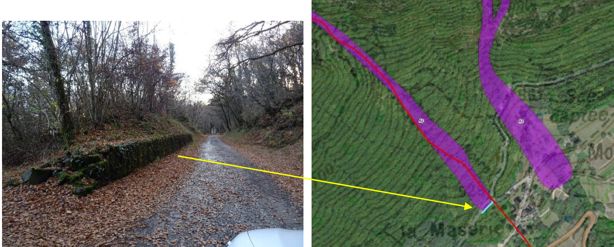
Figure 32 : Vieux mur/digue de 3 m de haut réalisé au départ du chemin de Montplan (525 m), dans l'axe du ruisseau de Combe Noire, pour protéger la bordure ouest de La Maserie (commune de St Pierre d'Albigny) des avalanches et des débordements du ruisseau.
