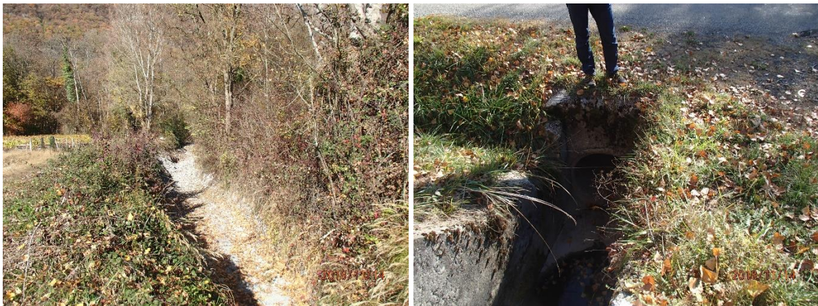
Figure 81:lit en amont de la RD 201 et passage busé sous la route
