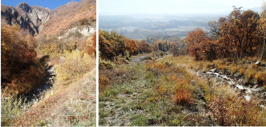
Figure 80:Chenal marqué du Cayan (à gauche) - rupture de pente et dépôts de matériaux en aval (à droite)
