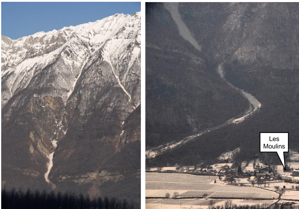
Figure 12 : Vue générale du couloir de Cayan en mars 2009 (à gauche) et détail du coude du ruisseau sur son cône de déjection, après les travaux de renforcement de berge de 2009 (à droite).
