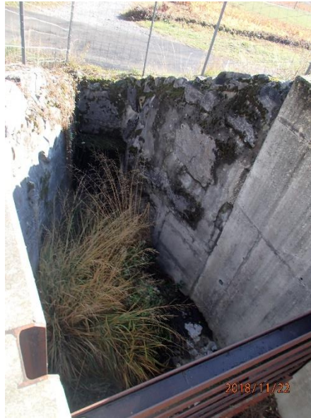
Figure 71 : ruisseau enterré dès l'aval de la plage de dépôt
