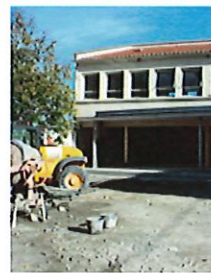
Travaux Médiathèque d'Ortaffa
