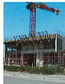
Travaux Pôle entrepreneurial
