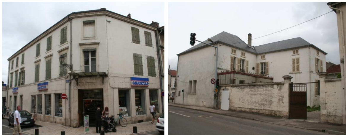
Façades du XIX ème siècle avec un enduit très lumineux et peu saturé.
