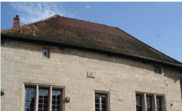
Figure 68 : La tuile plate est peu présente à Joinville alors qu'elle devait se trouver à l'origine à la place de la tuile mécanique
