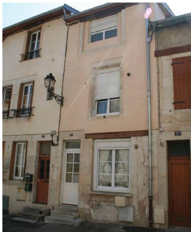
Figure 77 : Ventouses de chaudières, câbles électriques, coffrets gaz et électriques, boîtes aux lettres s'accumulent sur des façades étroites
