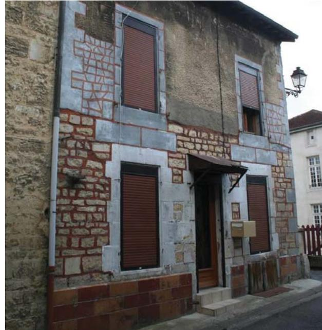
Figure 81 : Lorsque les teintes exotiques, les faux-appareillages, l'enduit ciment, le carrelage en soubassement et les volets roulants s'additionnent, l'effet est destructeur pour l'intégrité de l'édifice
