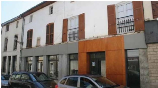
Figure 79 : Destruction d'un bandeau pour appliquer une devanture vraisemblablement trop haute
