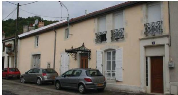
Figure 64 : La teinte de l'enduit à la chaux est reproduite sur le ciment par l'application d'un badigeon ou d'une peinture
