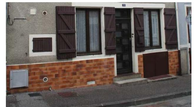
Figure 72 : Le carrelage appliqué en protection de soubassement n'a aucune légitimité architecturale
