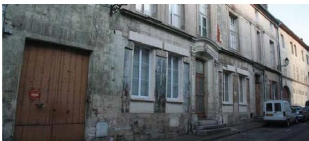
Figure 74 : Redimensionnement des baies avec fausses platebandes collées sur un linteau béton
