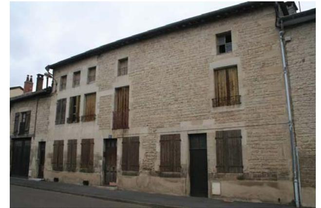
Figure 65 : Les façades dont la structure en moellons est laissée apparente constituent une minorité
