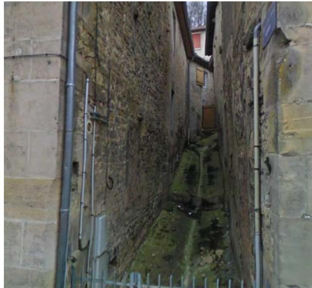
Figure 116 : L'écoulement d'eau non entretenu par le passage de Ville rend l'endroit insalubre. Le passage est d'ailleurs condamné.
