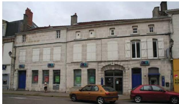
Figure 76 : Câbles électriques créant un faux bandeau entre le premier étage et l'attique
