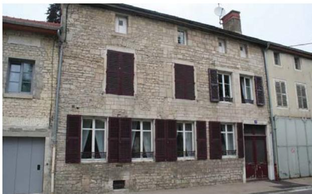
Figure 60 : Les moellons sont accompagnés de pierre de taille à l'appareil plus ou moins gros ou de briques pour réaliser les encadrements de baies.
