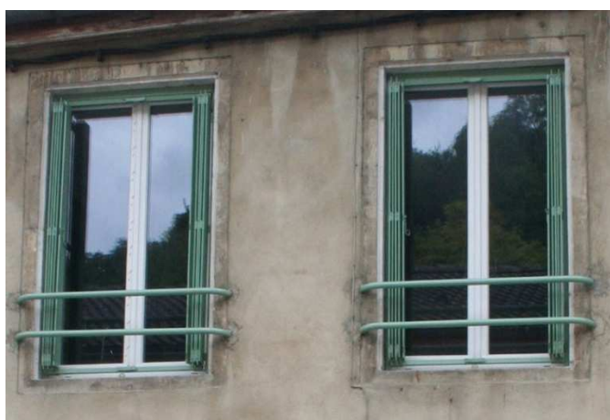
Barres d'appui en applique proscrites
