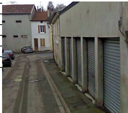
Garages 3 rue Charles Noël. Alignement de garages en ciment d'aspect très pauvre.
