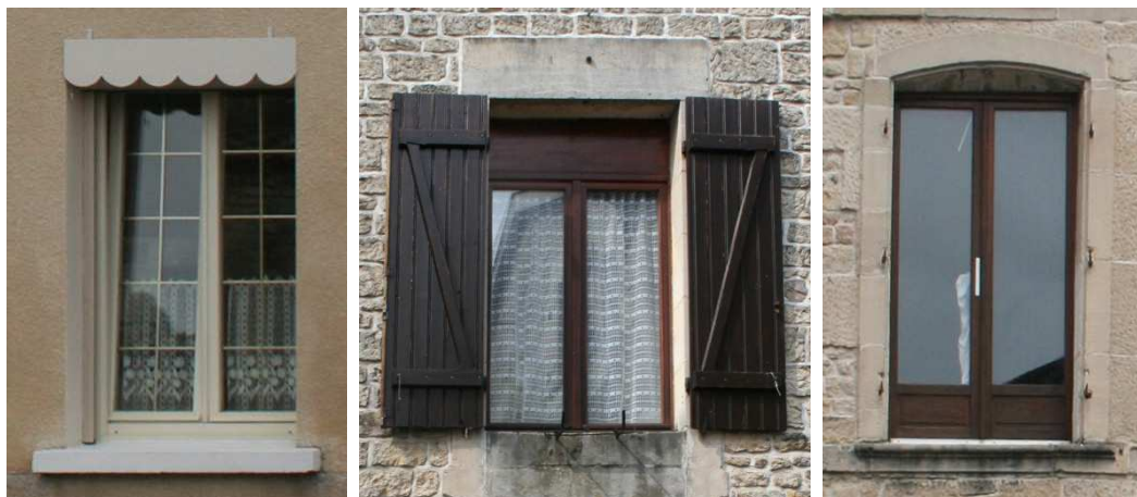
Fenêtres non-conformes sur existant en centre historique. De gauche à droite : petits carreaux dorés à l'intérieur du verre, éléments supérieurs et inférieurs trop larges.
