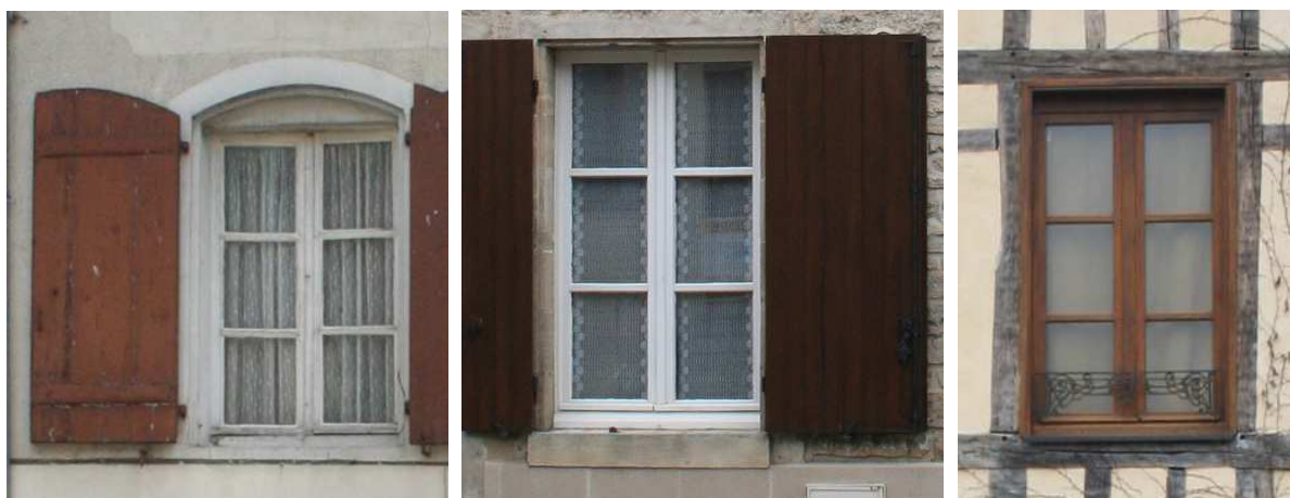
Fenêtres conformes en centre historique. La composition de deux vantaux de trois grands carreaux est la plus répandue dans Joinville. Elle s'accorde facilement avec tous types de matériaux et d'aspect de façades.
