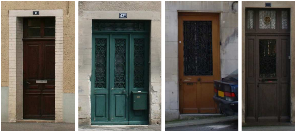
Portes conformes aux prescriptions du centre historique. La composition est faite de panneaux pleins ou vitrés de forme rectangulaire.
