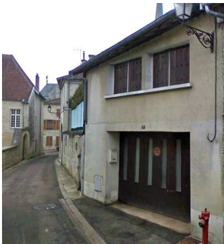
Immeuble 3 rue Marcand. Petit immeuble à un étage, enduit au ciment. Baies de l'étage et porte de garage hors typologie. Vis-à-vis malheureux avec l'auditoire de justice.
