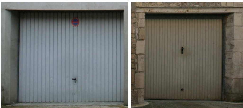
Portes de garage dévalorisantes en centre historique. Ces éléments standard s'intègrent mal dans les façades existantes.
