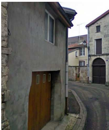
Immeuble 5 rue Saunoise. Edifice dont le rez-de-chaussée est formé de portes de garages et doté d'un seul étage. Enduit au ciment dévalorisant.
