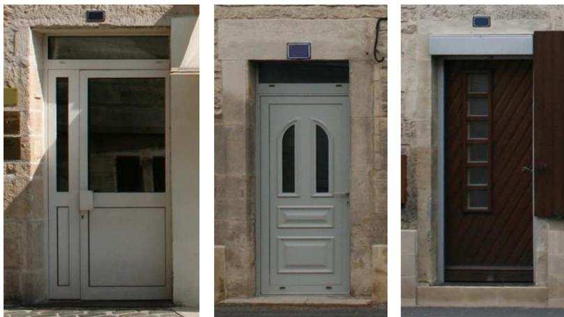
Portes non conformes en centre historique. De gauche à droite : menuiserie en PVC avec une finition industrielle, introduction de lignes courbes et biaisés dans le dessin de la porte sans justification.
