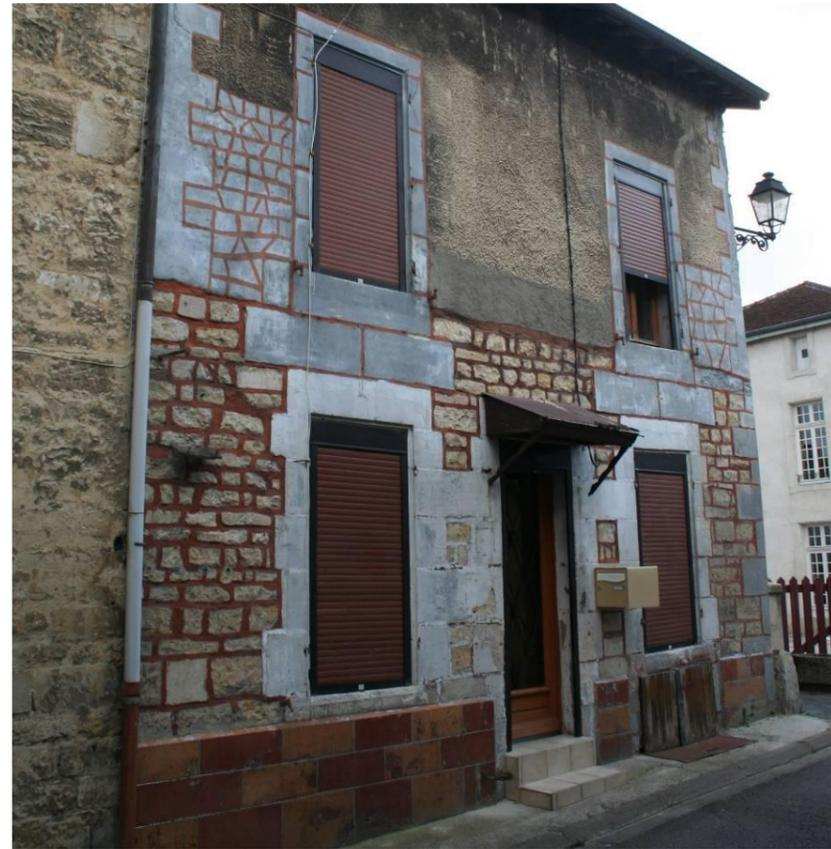
Figure 81 : Lorsque les teintes exotiques, les faux appareillages, l'enduit ciment, le carrelage en soubassement et les volets roulants s'additionnent, l'effet est destructeur pour l'intégrité de l'édifice
