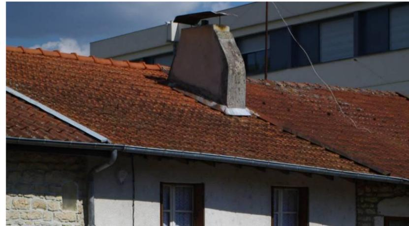
Figure 66 : La tuile mécanique couvre l'essentiel des constructions recensées
