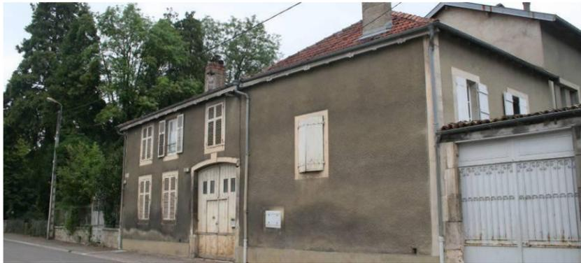
Figure 63 : L'enduit au ciment n'est pas un matériau d'origine
