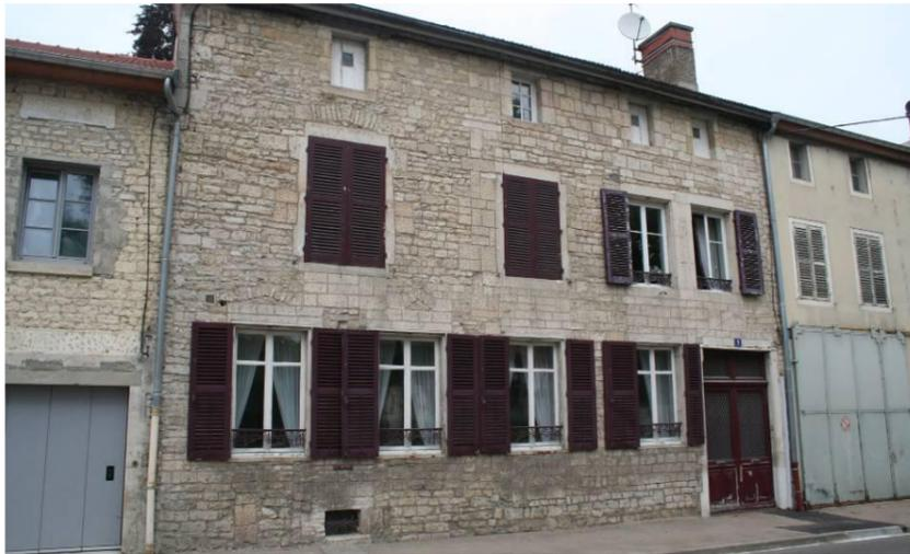
Figure 60 : Les moellons sont accompagnés de pierre de taille à l'appareil plus ou moins gros ou de briques pour réaliser les encadrements de baies.
