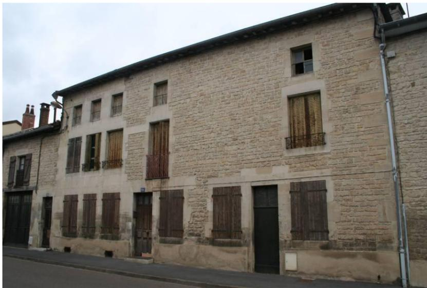
Figure 65 : Les façades dont la structure en moellons est laissée apparente constituent une minorité
