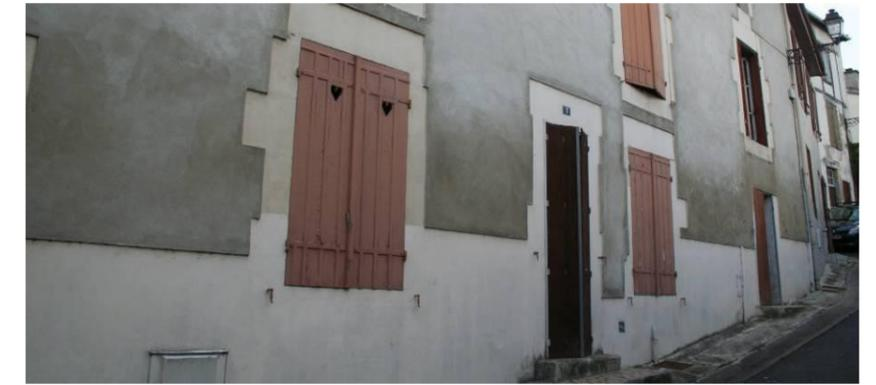
Figure 70 : Un enduit mal appliqué vient en saillie des encadrements de baies. Par ailleurs, le ciment pose de sévères problèmes de gestion de l'eau à travers la maçonnerie.
