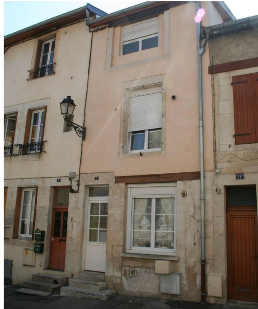
Figure 77 : Ventouses de chaudières, câbles électriques, coffrets gaz et électricité et boîtes à lettres s'accumulent sur des façades étroites
