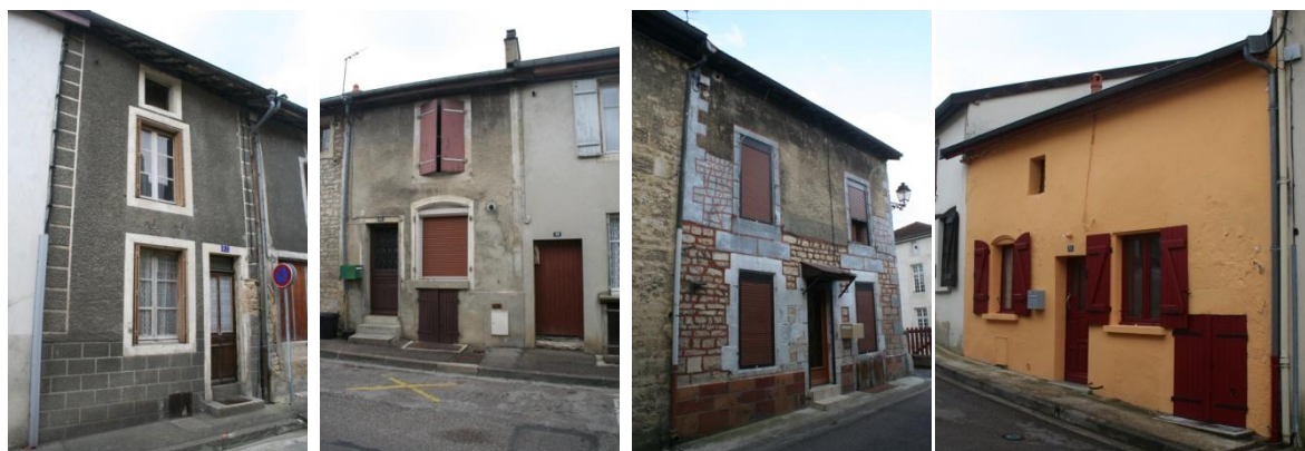
Exemples de teintes problématiques en centre historique : ciments gris, polychromie et couleurs trop saturées.
