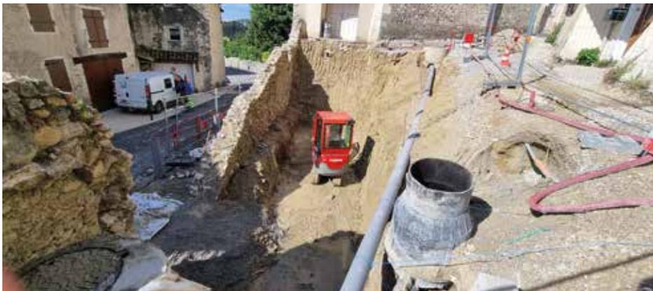
De grands travaux sont en cours, déplacement de l'ensemble des réseaux d'eau potable, d'assainissement, d'électricité et de télécommunications pour permettre la construction d'un escalier d'accès depuis la rue Zamenhof à la Chapelle Saint Blaise. Ces travaux sont réalisés par l'entreprise Rivasì, titulaire du marché, dans la continuité de la réfection complète des rues Casse-Cul, du Patronnage et de Gustave Pinet.
