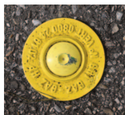
Cloutage au sol indiquant la proximité d'une canalisation de gaz
