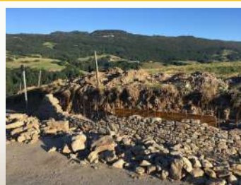
Réfection mur de la route du Péroux
