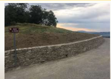
Réfection mur de la route du Péroux
