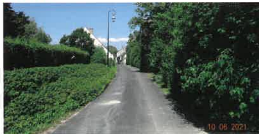
APRÈS les travaux
