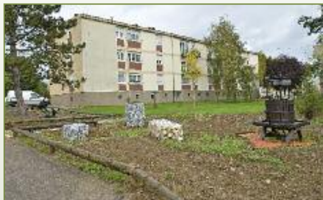
Aménagement en cours de réalisation entre la rue Jean Jaurès et la rue du Maréchal Leclerc
