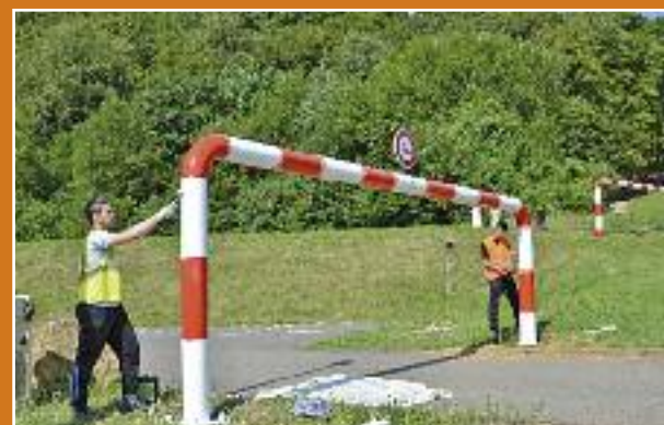
Les jeunes ont également travaillé à la remise en peinture des portiques du Fond Saint Martin
