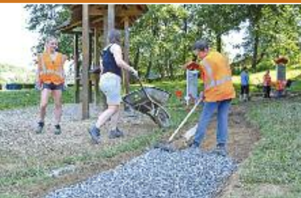
Après enlèvement de la terre, pose et ratissage du gravier
