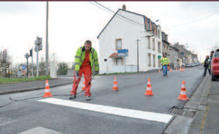
Matérialisation des lignes sur la chaussée.
