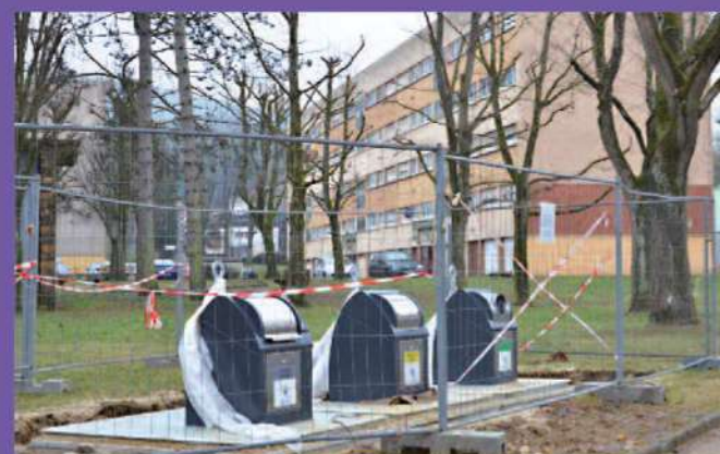
Des conteneurs enterrés ont été également installés rue Chanteraine
