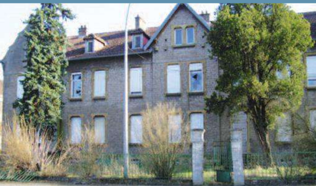
L'ancienne Maison des Syndicats va devenir la Maison du Projet
