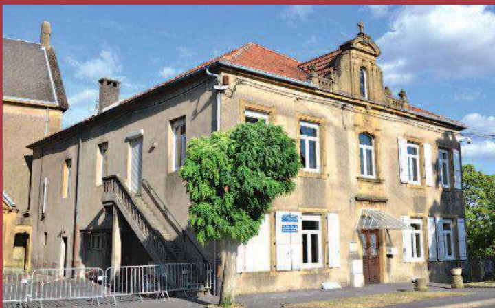
32 nouvelles fenêtres et de nouveaux volets (ici en cours de pose) pour le presbytère catholique
