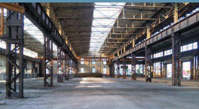
De vastes surfaces vont être aménagées dans le 5 bâtiments conservés (ici l'ancien bâtiment locotrailleurs)
