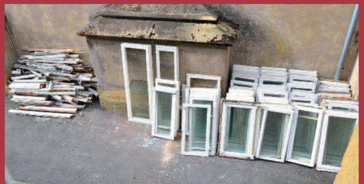
Les fenêtres déposées avant leur départ au recyclage
