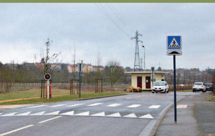
Deuxième plateau ralentisseur, près de la traversée de la voie ferrée
