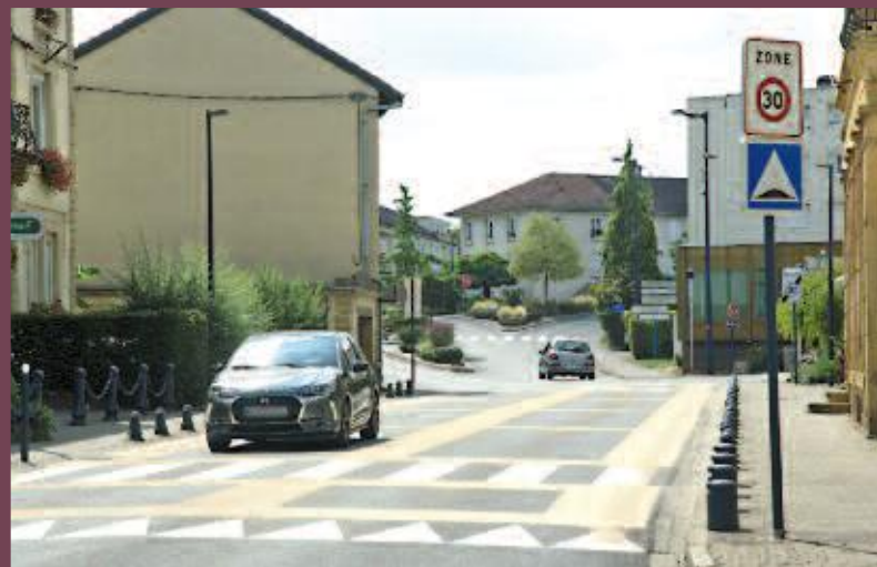
Rue Mondon : décapage de l'ancienne chaussée, macadam et pavés ... et juste après, la pose des bandes de résine en relief sur la zone 30
