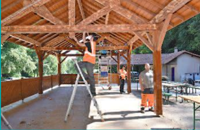
Entretien des abris du Fond Saint Martin : application de la lasure
