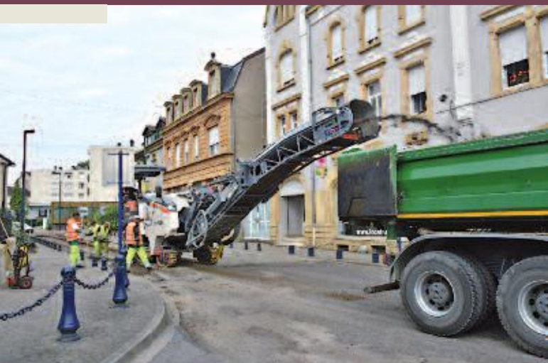
Rue Mondon : décapage de l'ancienne chaussée, macadam et pavés ... et juste après, la pose des bandes de résine en relief sur la zone 30
