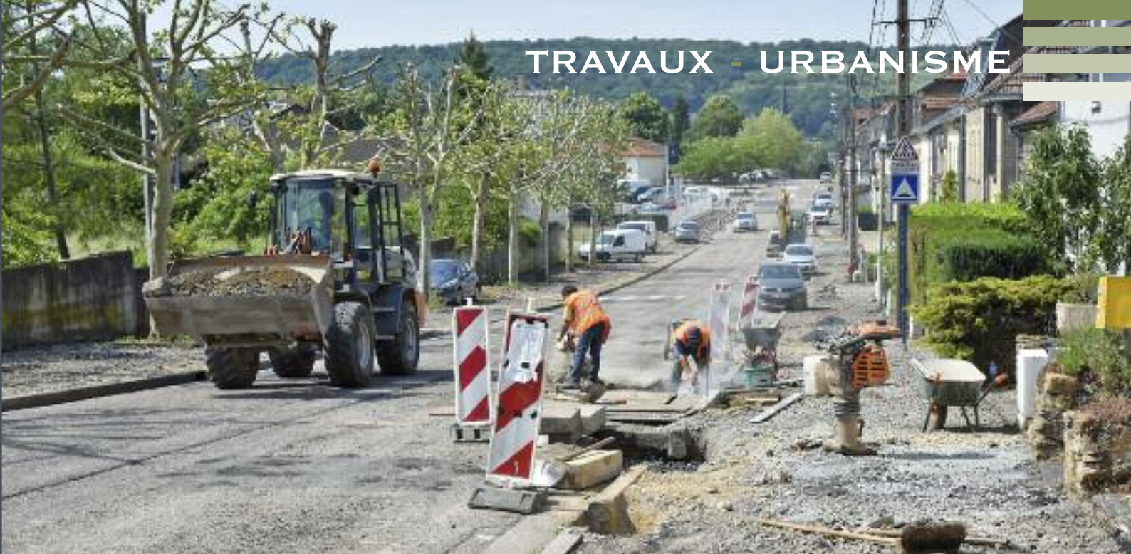
Hommes et machines en action depuis le mois d'avril 2019 pour rénover chaussée et trottoirs
