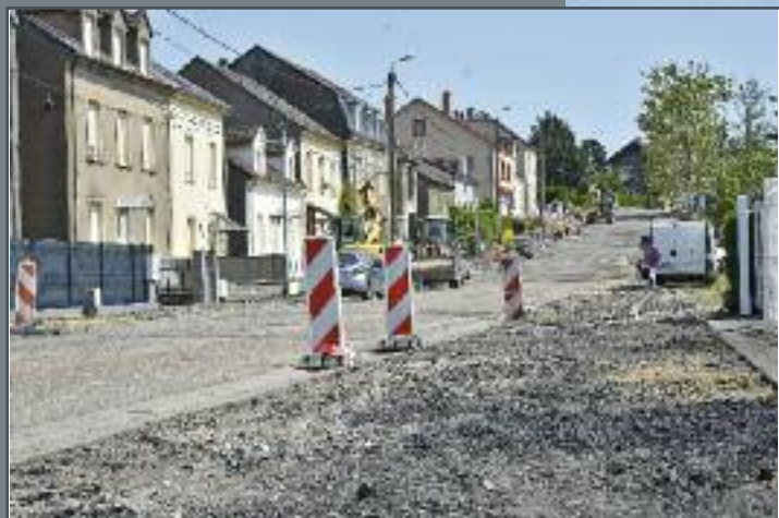
Les trottoirs aussi sont rénovés en profondeur
