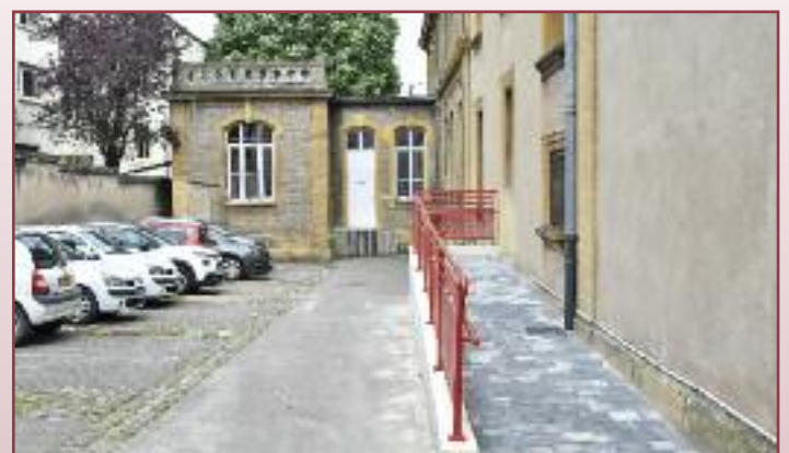
Un équipement très prochainement complété par des places de stationnement dédiées
