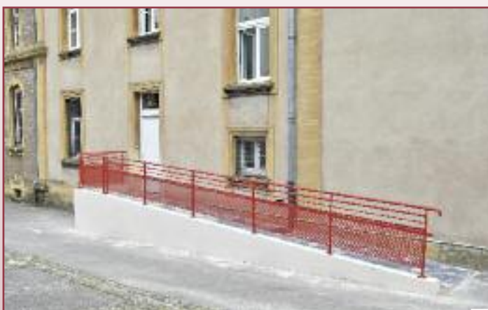
La rampe d'accès pour les personnes à mobilité réduite
