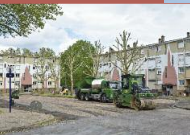
Le bas de la rue du Général Leclerc pendant les travaux
