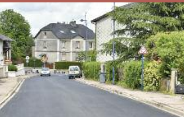
La portion de chaussée rénovée
