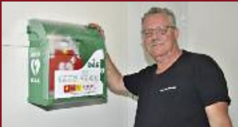
Eric Visbecq installe le défibrillateur dans les toilettes du Fond Saint Martin
