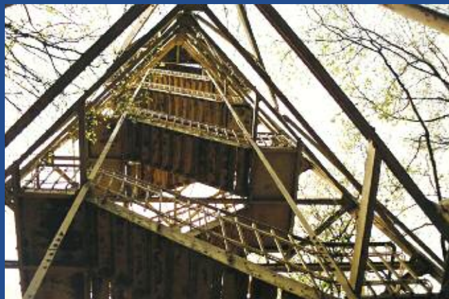
Structure métallique de la Tour de Drince. Symbole du passé sidérurgique et du monde de l'usine de Rombas.
