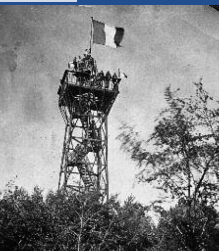
Inauguration de la Tour (métallique) de Drince le 11 septembre 1932. Auréolée de drapeaux français, la tour francise le lieu où se voient, vers l'ouest, les Hauts de Meuse devant Verdun symbole de la victoire française dans la Grande Guerre. A l'emplacement de l'ancienne tour de bois qui regardait vers l'ouest les victoires allemandes de 1870 et célébrait la première annexion.
