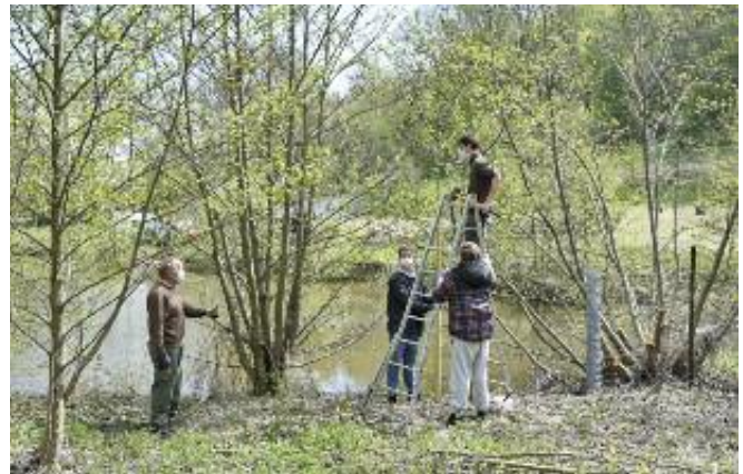
Construction du parc à moutons par le service des Espaces Verts et des Emplois jeunes
