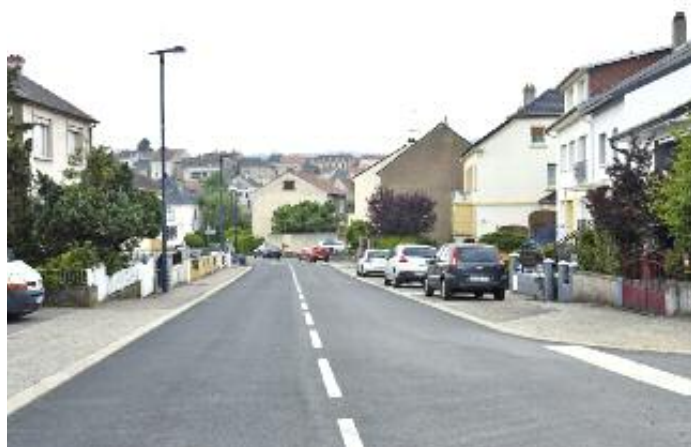
Rénovation rue de Villers
