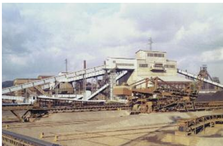
La première des deux installations de l'agglomération LURGI, est destinée au broyage-criblage du minerai et des combustibles en « fines ». Elle est desservie par un étonnant faisceau de convoyeurs ou bandes transporteuses. Au-devant, le parc de stockage des fines. (Photographie datée 16 octobre 1963)
