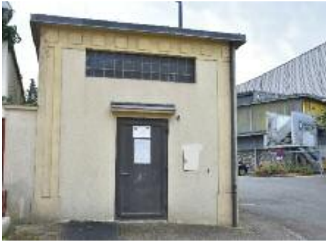
Un nouveau transformateur pour le quartier du Centre-Ville
