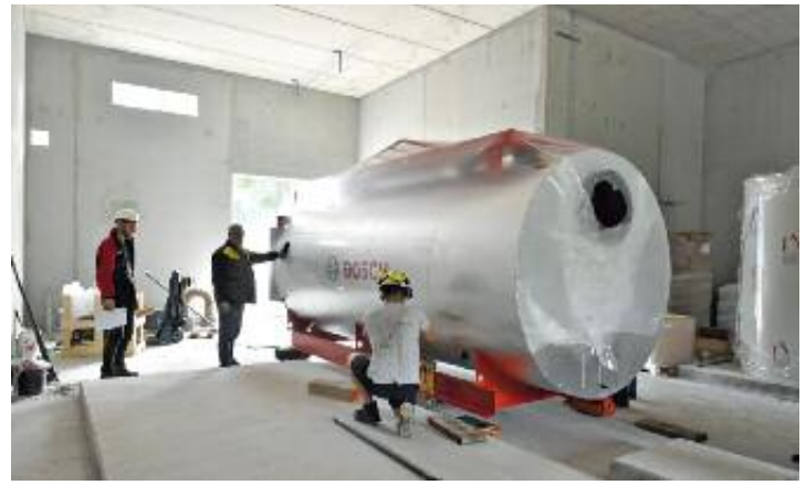
Mise en place de la chaudière gaz dans la chaufferie
