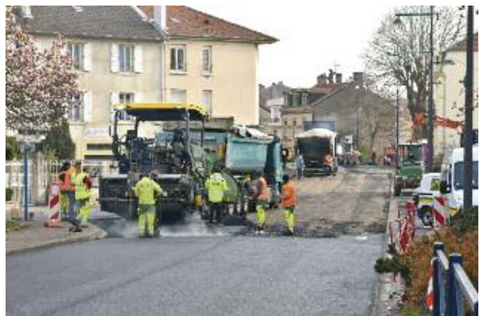
Rénovation rue de la Paix
