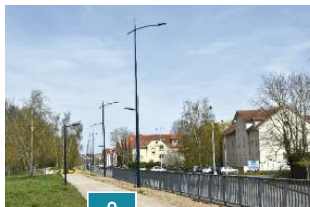
Les nouveaux lampadaires rombasiens sont systématiquement éclairés par leds
