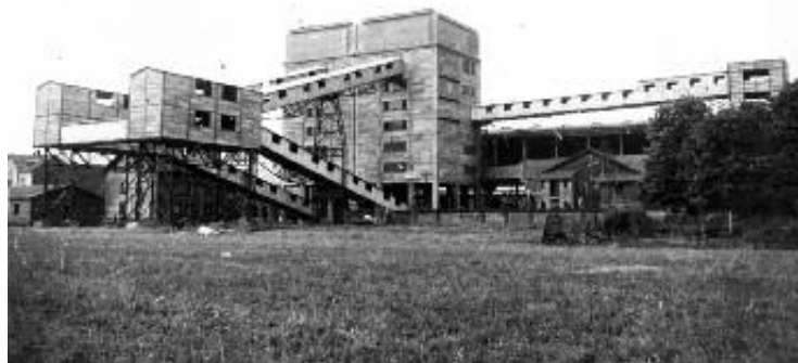
SLAR (Société Lorraine des Acières de ROMBAS) Achèvement de la construction du concasseur à minerai inauguré en mai 1950, et proche d'une station de criblage rendue opérationnelle la même année. (Photographie du 28 mai 1949)
