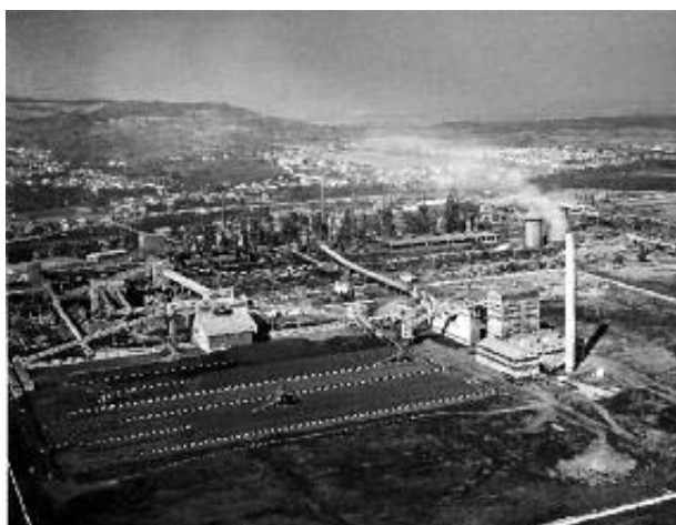
Face à l'impressionnante batterie des 8 hauts fourneaux, de gauche à droite et à partir du concasseur, se dressent les deux grandes installations formant la nouvelle agglomération dite LURGI en fonctionnement depuis juillet 1963. (Cliché aérien daté 1er juin 1966)
