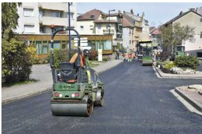
Rénovation de la rue Raymond Mondon
