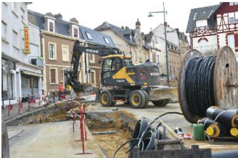
Mise en place du réseau de chaleur, rénovation de différents réseaux et rénovation de la chaussée, rue de Versailles
