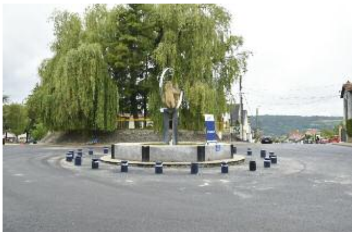
Rénovation du giratoire, rue de la Tour
