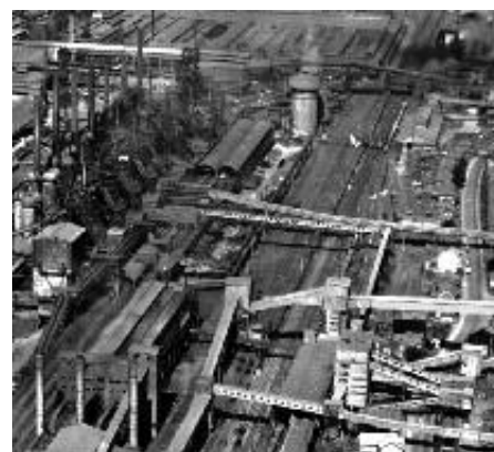
Au-devant de ses 3 cheminées et proche des hauts fourneaux, s'allonge la première agglomération de l'usine de Rombas mise en service en janvier 1959. À droite, en face d'elle et au-delà des voies ferrées, le concasseur à minerai construit en 1950 lui offre alors une indispensable complémentarité. (Cliché aérien de 1969)
