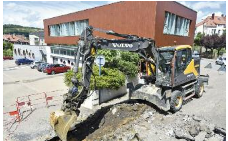
Raccordement de la Maison du Lien Social au réseau de chaleur
