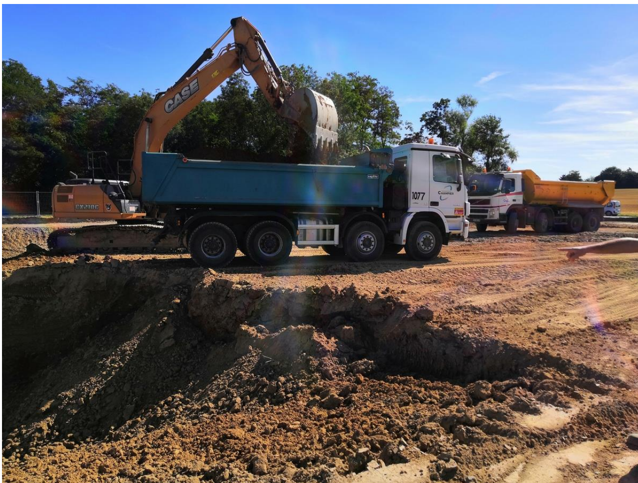
3 - Travaux de terrassement pour la construction du bassin de rétention des eaux de Combe-Radix
