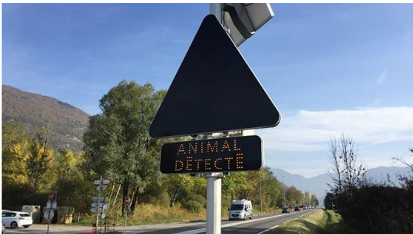
6 - Des détecteurs de faune ont été installés sur la commune de Ruy-Montceau
