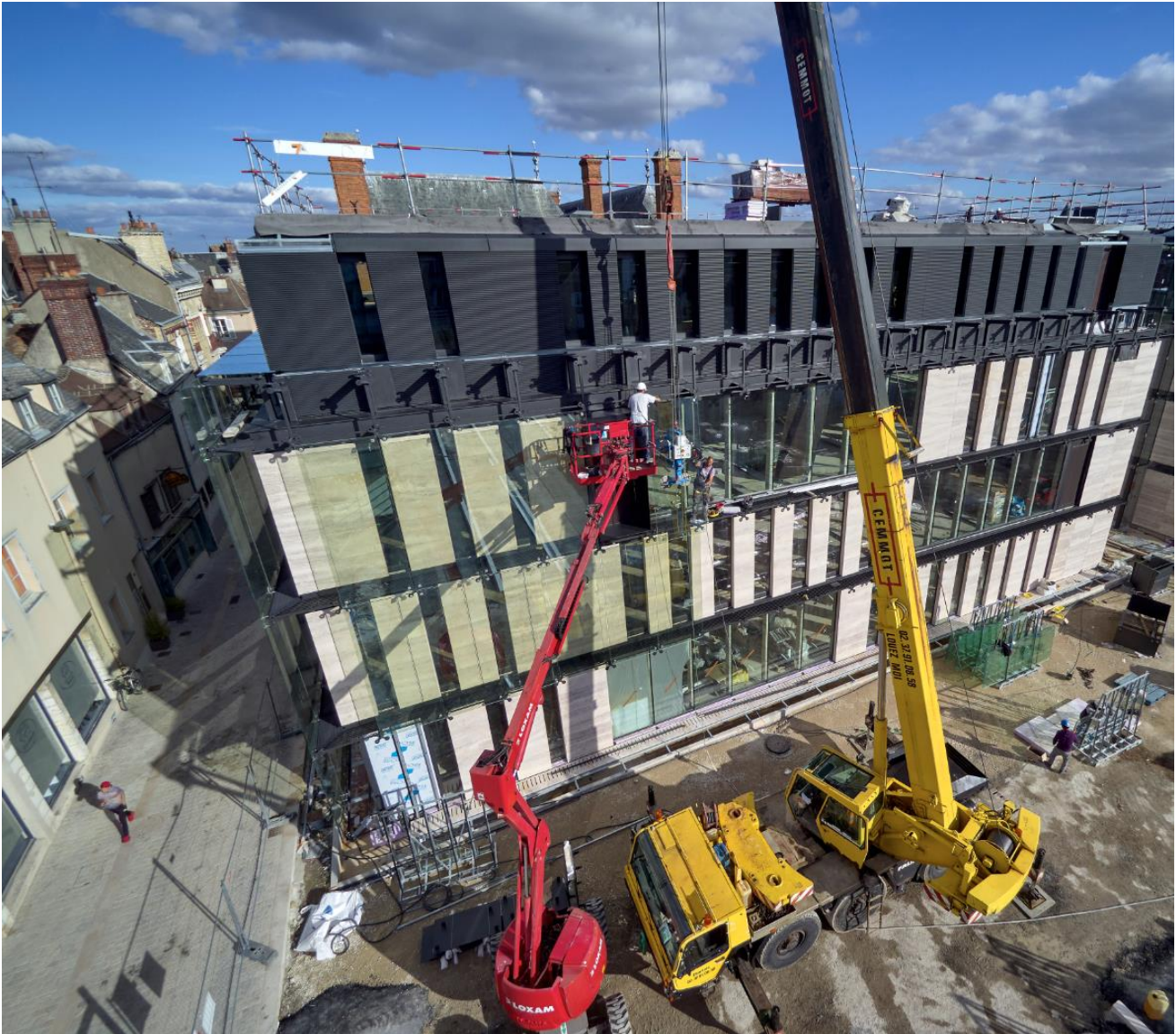
Travaux sur les façades, 2019.
