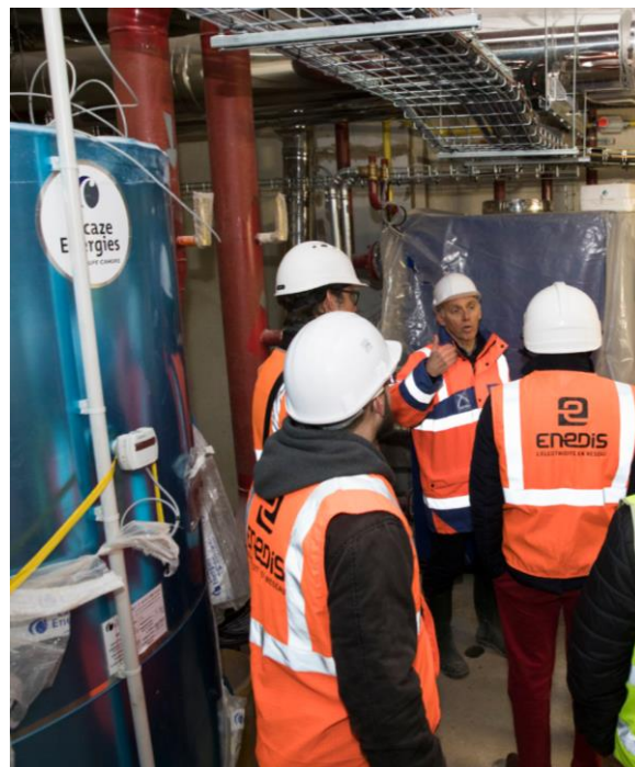
Gestionnaire du réseau d'électricité en France, Enedis demande à visiter le chantier du Pôle administratif et ses dispositifs BBC
