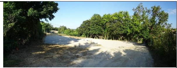
Zone en construction
