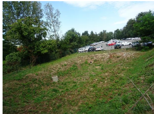
Bassin de rétention des EP du parking
