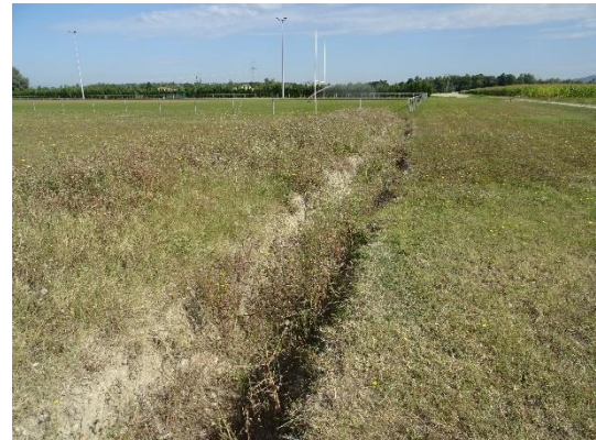
Fossé de drainage des eaux pluviales
