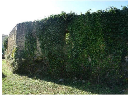
Mur avec lierre clôturant la parcelle
