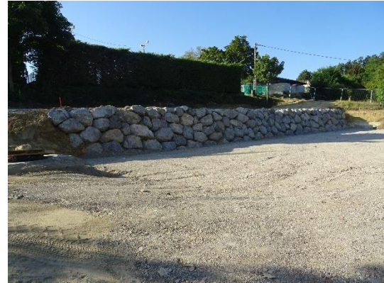
Enrochements pour stabiliser le futures constructions en étage
