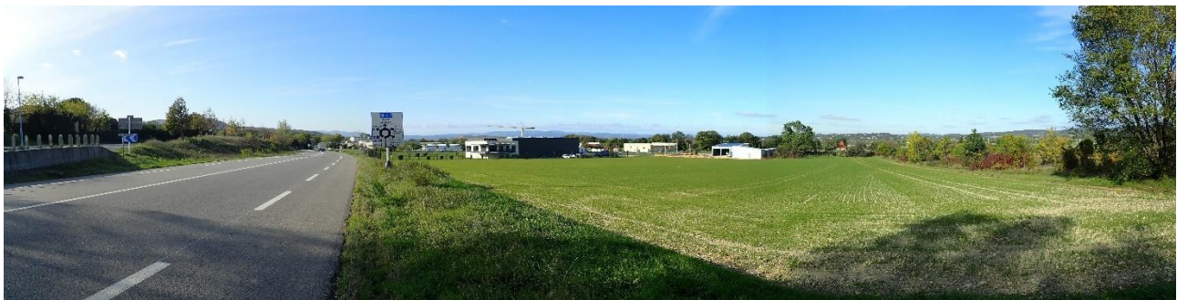
Photographie 1 – Vue de la partie ouest de la future zone AUe le long de la RD104
