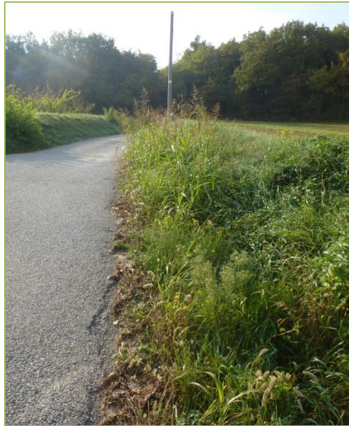
Photographie 14 - Végétation de bords de route (Eco-Stratégie, le 02/11/2016)
