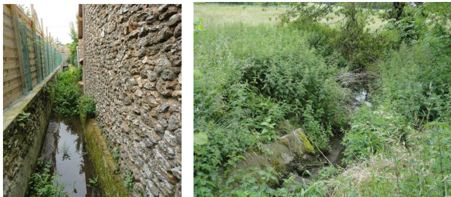
Le rû au niveau du Bas-Houlbec, canalisé en milieu urbain et d'écoulement naturel par la suite
