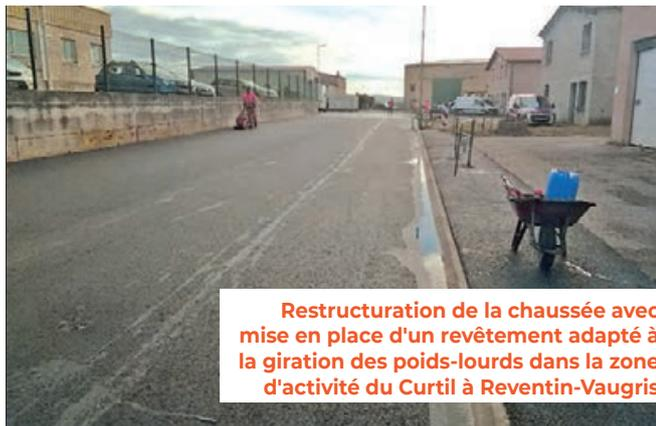
**Restructuration de la chaussée avec mise en place d'un revêtement adapté à la giration des poids-lourds dans la zone d'activité du Curtil à Reventin-Vaugris**
