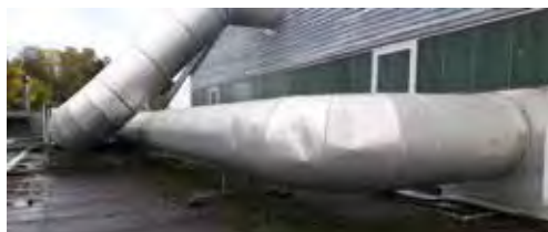
Toit centre culturel - 4 novembre 2019
