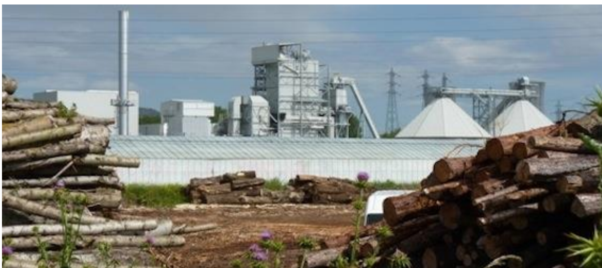
Photo de la centrale biomasse de Pierrelatte
