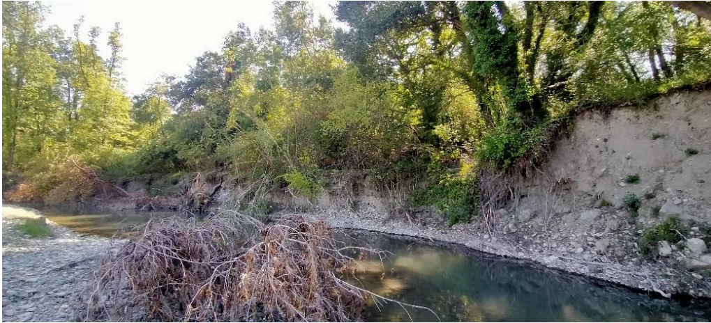
Effondrement de berge
