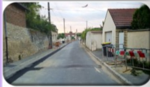
Effacement des réseaux rue Edouard Collas
