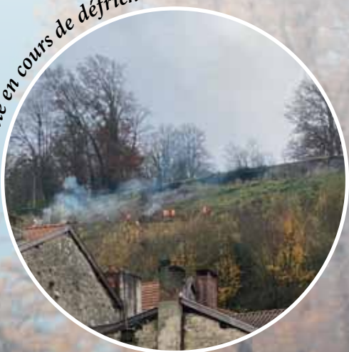
Le défrichage quasi terminé
