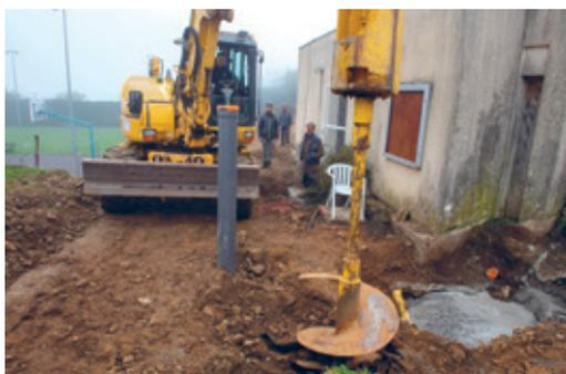
Forage des pieux pour le soutènement de l'extension du bâtiment
