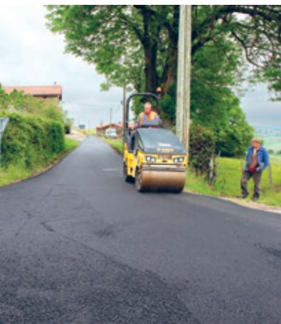
**Réalisation d'un bicouche par gravillonnage sur le chemin de la Bâtie**
