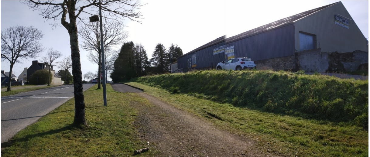
Vue depuis le Nord-Ouest de la zone, en bordure de la RD32 (Boulevard de la République)
