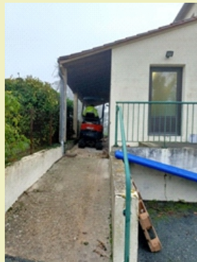
TRAVAUX DE RACCORDEMENT AU TOUT A L'EGOUT
