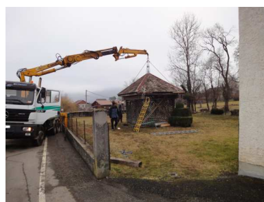
Déplacement de la grenette : enlevée du jardin du presbytère, elle est désormais réimplantée devant l'école, place de la Mairie
