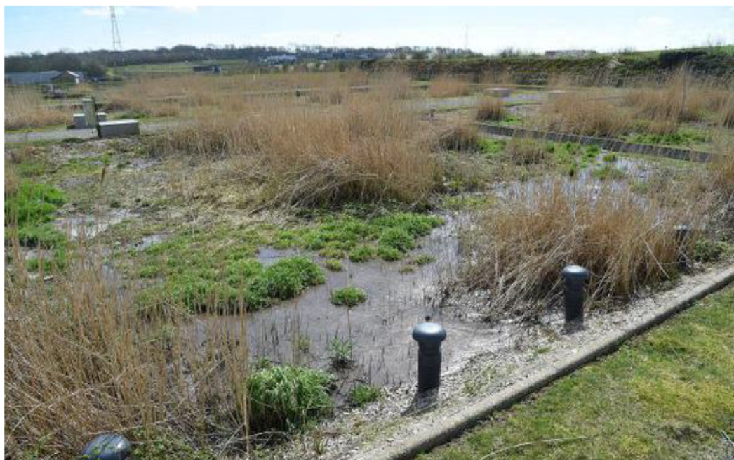
La station d'épuration est directement voisine de la zone d'activités. PH. ARCHIVES MARC DEMEURE
