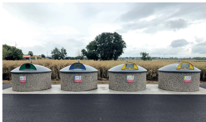
PAV semi-enterré, rue de Banand
