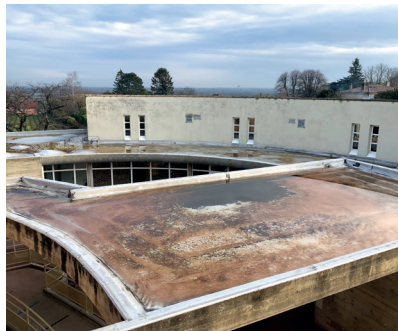
Toit de l'école - Avant travaux
