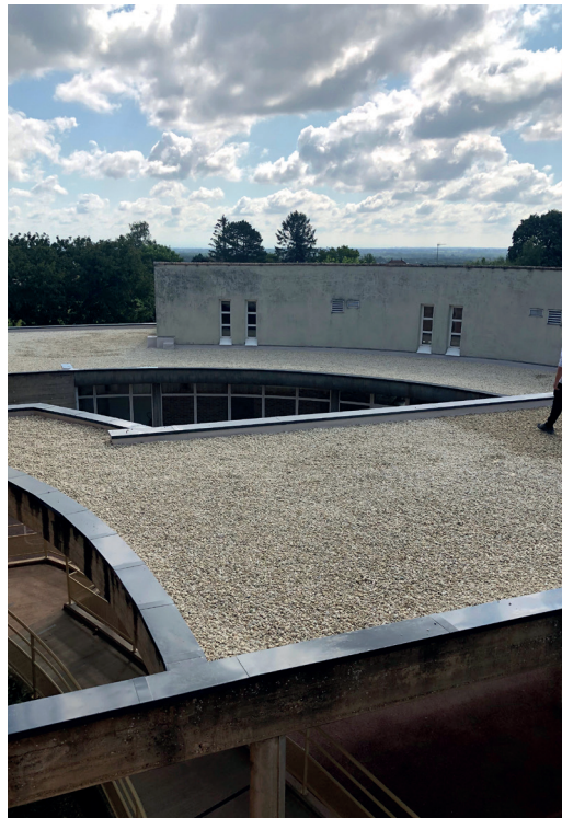
Toit de l'école - Après travaux
