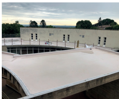
Toit de l'école - Pendant travaux
