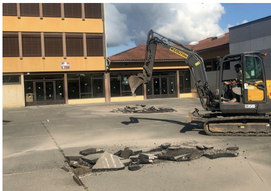
Retrait du bitume sur la surface des îlots.
