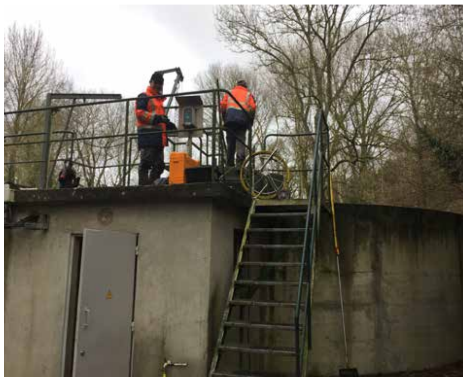
Agents techniques sur une intervention « Assainissement »
