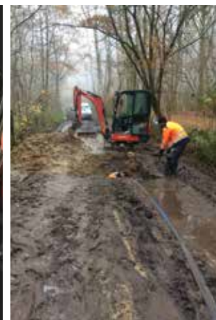
Agents techniques sur fuite à St Arnoult
