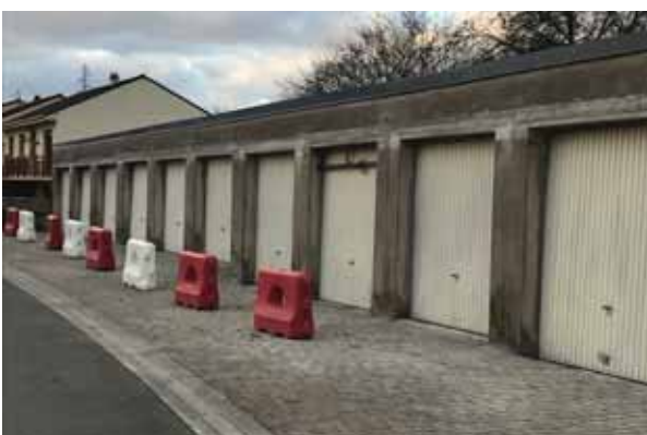
Remplacement des linteaux sur douze garages appartenant à la Commune rue Josquin des Prez.
