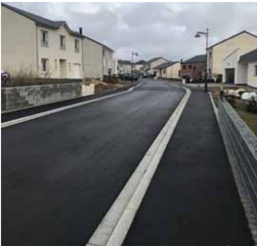
La voirie définitive dans la dernière tranche du lotissement Les Arbrisseaux a été partiellement réalisée. La fin des travaux se fera dès que les conditions climatiques le permettront.
