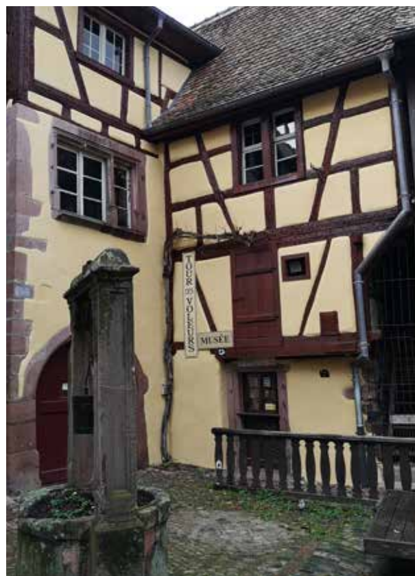
Rénovation de la façade de la maison de vigneron
