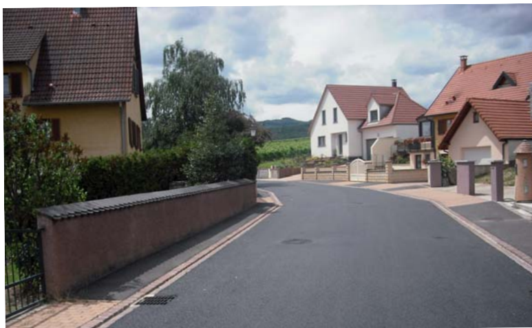
Rue Windmuehl, pose de l'enrobé.
