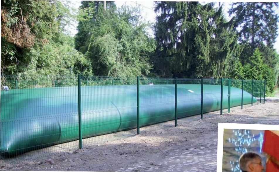
Mise en place d'une réserve incendie à la gare d'une capacité de 180 m 3 .
