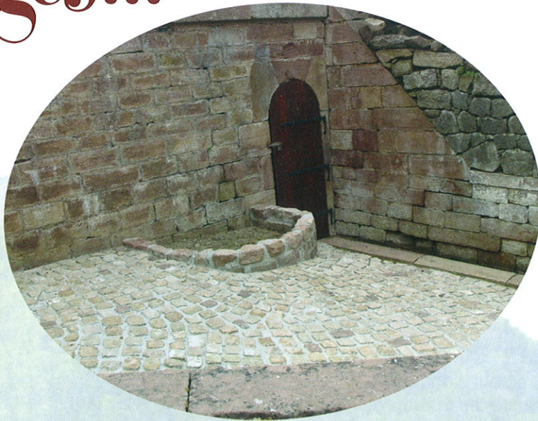
Travaux au Toerel
