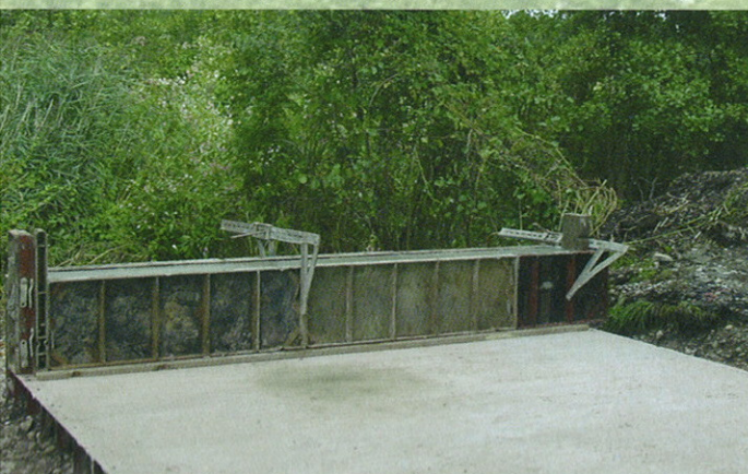
Réfection du Pont de la Werb
