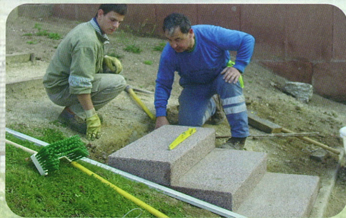
Travaux de réfection de l'escalier extérieur de la Salle des Fêtes
