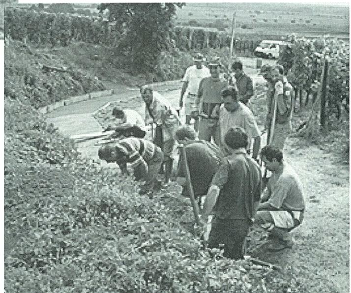
Suite aux travaux gaz et EDF, un glissement de terrain est survenu sur le talus dans la rue de l'Ancienne Tuilerie, un enrochement a été effectué: coût des travaux: 30 000 F (4 573,47 €). Ce chantier nous a donné l'occasion de commencer un aménagement, ce qui nous permet d'avoir un superbe point de vue sur notre magnifique village.
