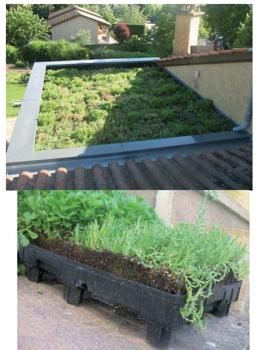
Exemple de toiture-terrasse végétalisée et bacs pré-cultivés
