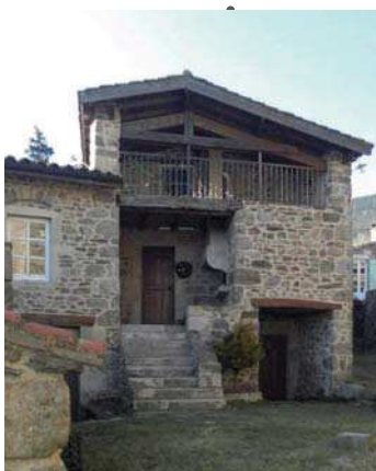
Exemple de débord de toiture
