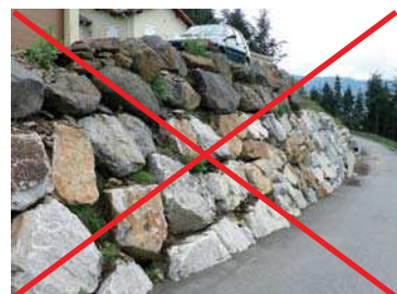
Exemple d'enrochements de type cyclopéen
