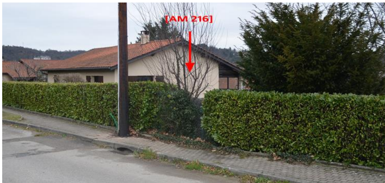
< ^ Vue du passage d'eau depuis la rue de Vaunoy – séquence centre
